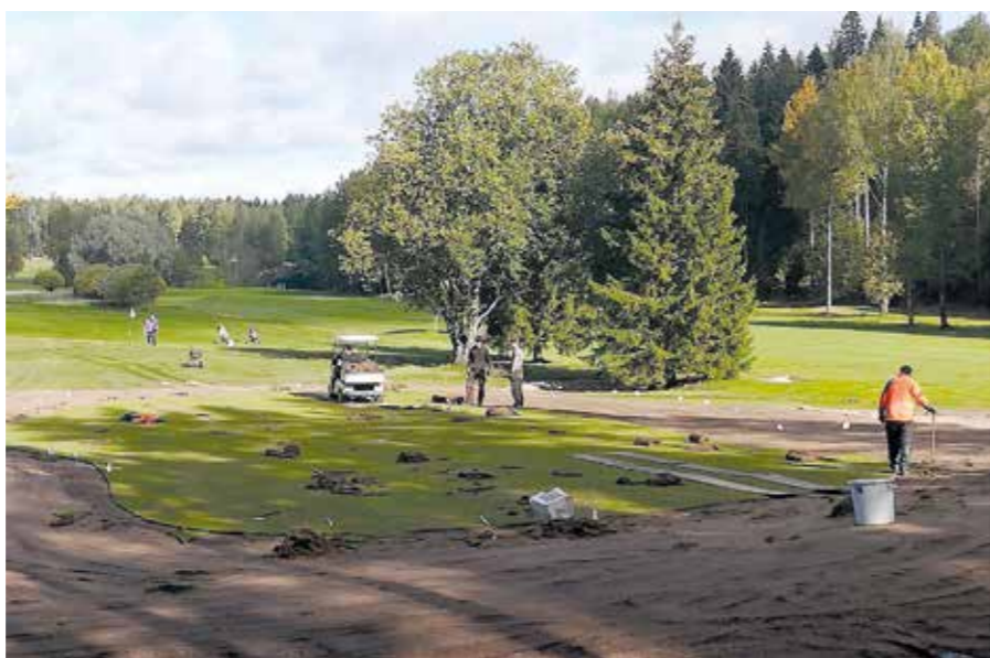
Luukin uusittu 12. viheriöalue työn alla syyskuussa 2021. Viheriön muoto ja bunkkeri uusittiin ja kaksi kuusta poistettiin. Viheriö on aiempaa suurempi ja siinä on paljon enemmän lipunpaikkoja. Viheriö sekä uudelleen muotoiltu vesialue kuvassa oikealla näkyy nyt lähestymislyöntipaikkoihin aiempaa paremmin. Piilossa olleet sokko-ajat oikealla ja viheriön edessä ovat peitetty.
