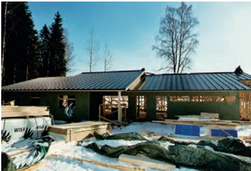
Luukin uutta klubitaloa rakennetaan.
